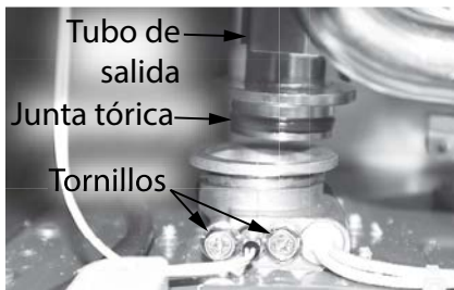
Figura 233 - Ubicación de la junta tórica.
