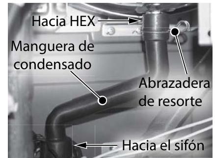
Figura 240 - Retiro de la manguera de condensado.
