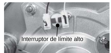
Figura 6 - Interruptor de límite alto (puerta del quemador).
