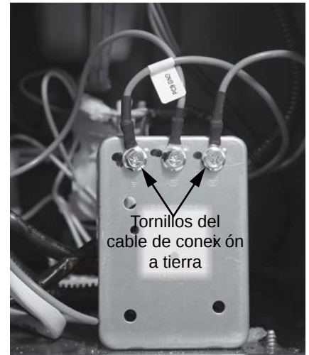
Figura 59 - Ubicación de los cables de conexión a tierra.
