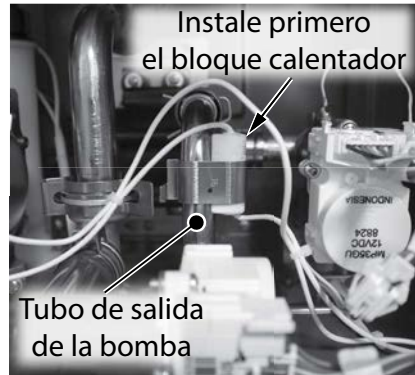
Figura 38 - Instale el bloque calentador en el tubo de salida de la bomba.
