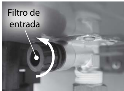
Figura 228 - Ubiqúe y retire el filtro de entrada.
