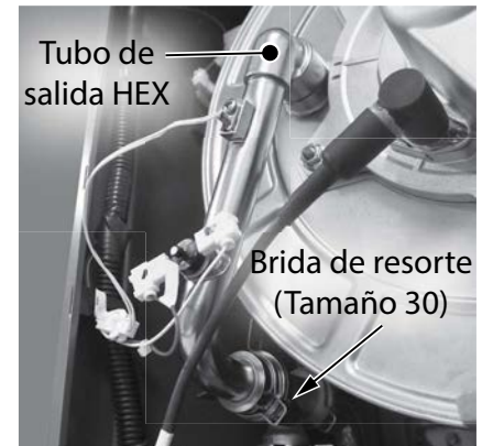
Figura 139 - Retire la brida de resorte que fija el tubo de salida HEX.
