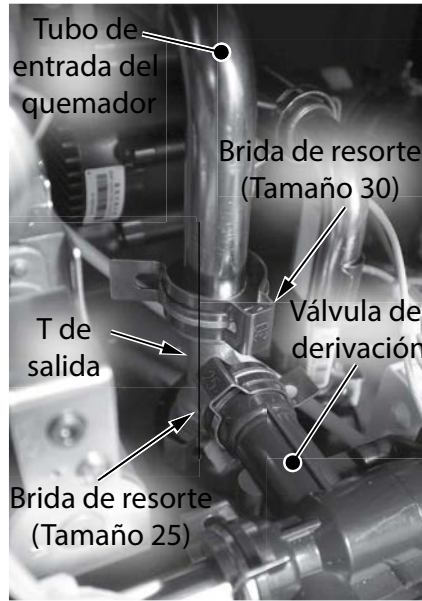
Figura 247 - Retire las dos bridas de resorte de la T de salida
