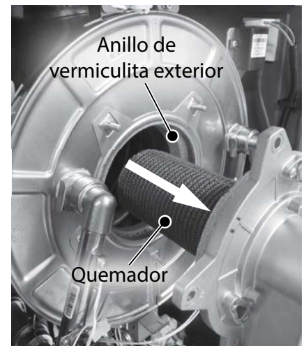
Figura 120 - Retire el conjunto de puerta del quemador.
