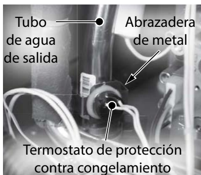
Figura 45 - Retire el termostato de protección contra congelamiento.
