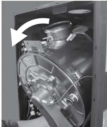
Figura 150 - Retire el intercambiador de calor.
