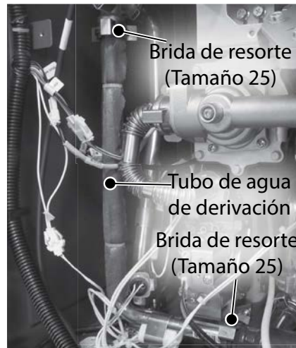
Figura 211 - Retire las bridas de resorte del tubo de agua de derivación.
