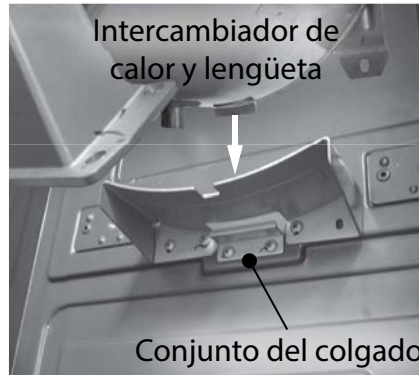
Figura 155 - Inserte la lengüeta en el colgador.
