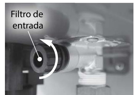
Figura 209 - Retiro del filtro de entrada.
