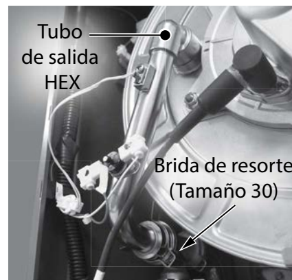
Figura 197 - Retire la brida de resorte que fija el tubo de salida HEX.
