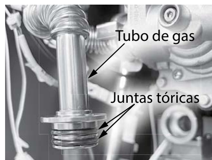
Figura 84 - Reemplazo de la junta tórica (dos juntas tóricas).
