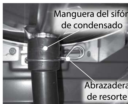
Figura 264 - Abrazadera de resorte, manguera de condensado.
